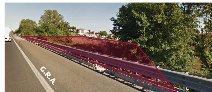
Localizzazione da Google Street View
